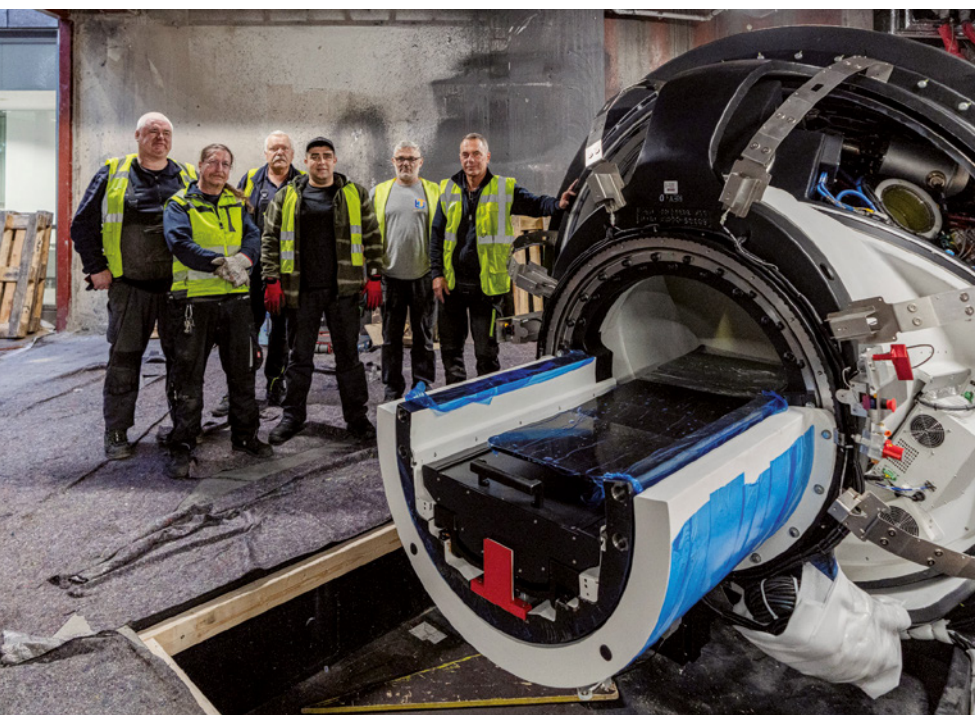
Für das Hightech-Gerät wurde extra ein Fundament ausgehoben. Aufbau und Installation übernahm ein Team aus Spezialisten aus Deutschland und den USA.
