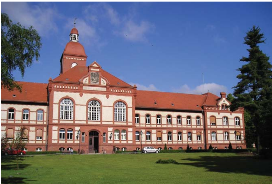
Seit Herbst 2007 planen und steuern die Brandenburger alle Patienten- und Materialtransporte, die innerhalb der Klinik anfallen, mithilfe eines zentralen IT-Systems. BILDER: RUPPINER KLINIKEN
