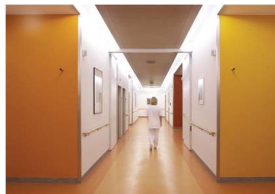
Warmweißes Licht ohne Blendung erzeugt die Vouten-Beleuchtung mit dem Lichtbandsystem Tecton-Tetris auf den Gängen des Marienkrankenhauses.
