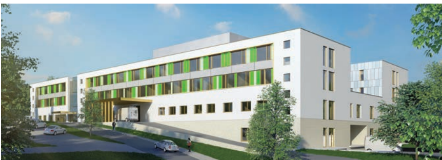
Der Neubau der Glantal-Klinik Meisenheim ist mit dem DGNB-Vorzertifikat in Silber ausgezeichnet worden.
