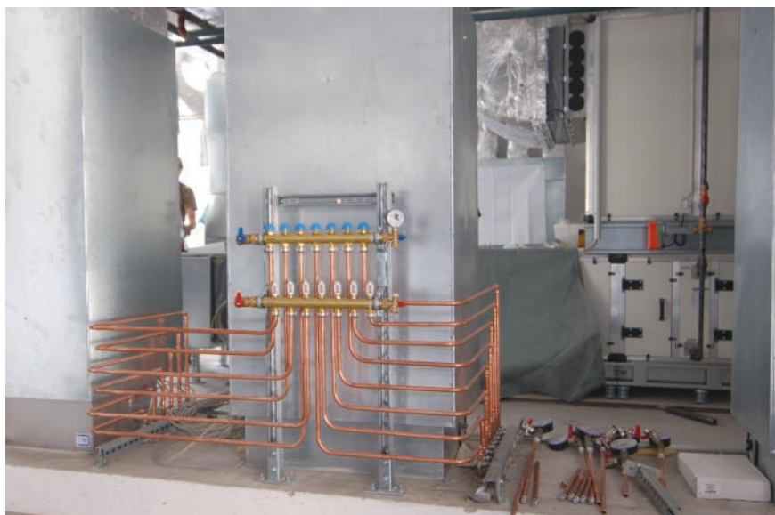
Die OP-Ebene 4 wird von oben mit Wärme versorgt. Der Verteiler ist weitgehend fertig montiert, die Dämmschalen müssen noch um die Rohre gelegt werden.
