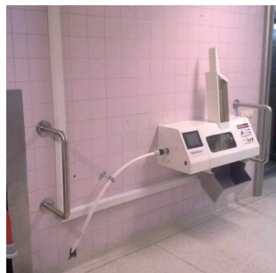
Das System wird in Sternform – von ausgewählten kritischen Stationen bis zum Labor – als Punkt-zu-Punkt-Ausführung installiert. Der Rohrdurchmesser beträgt 25 mm, die Transportgeschwindigkeit 10 m/s.
