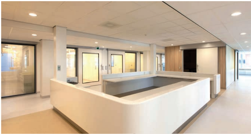
Der Grundaufbau aller Tresen: Auf einem Podest und Sockel aus Edelstahl sitzt eine Spanten-Rahmen-Konstruktion aus Multiplexplatten auf. Sie bildet das Skelett, auf das die selbsttragenden Mineralwerkstoffteile aufgelegt und anschließend zusammengefügt werden.
