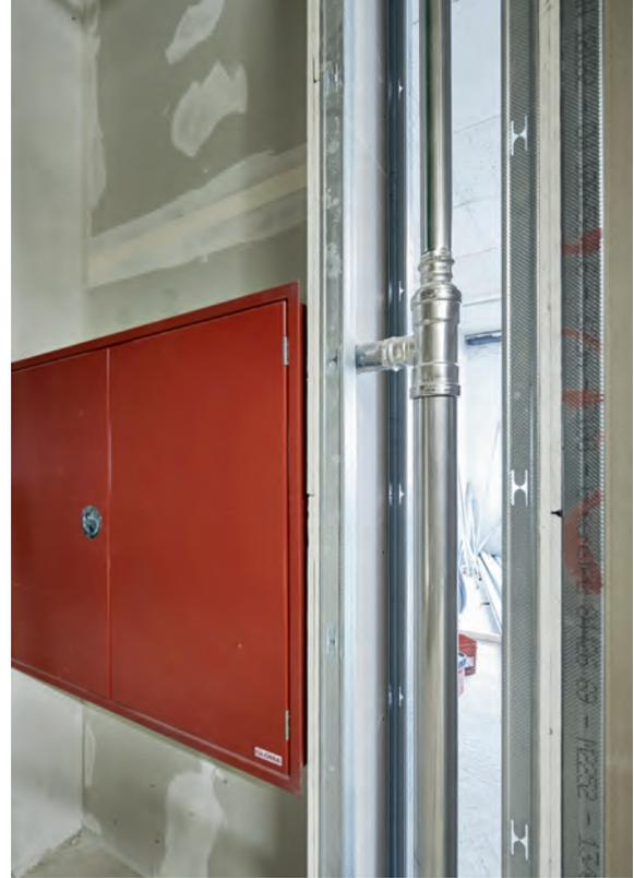
Im Erweiterungsbau selbstverständlich: die strikte Trennung zwischen Trinkwasser- und Löschwasserinstallationen. Auch hier ist das Rohrleitungsnetz aus Edelstahl (Sanpress Inox von Viega).
