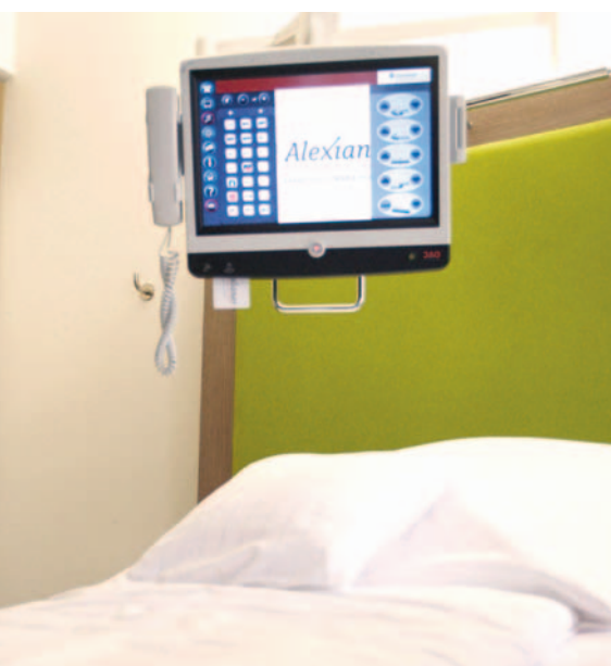
Im Krankenhaus Maria-Hilf in Krefeld sind 76 Betten mit der integrierten Vernetzung ausgestattet.
